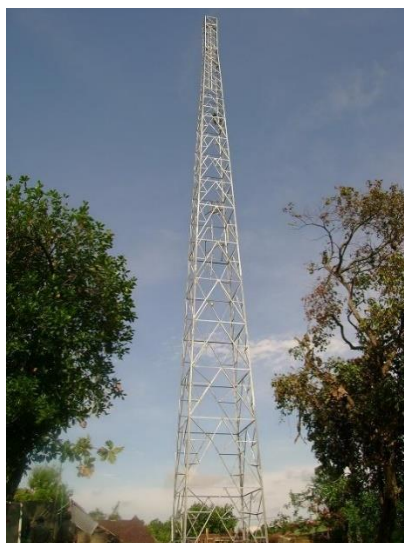
Gambar 3. Menara Telekomunikasi Seluler Empat Kaki
