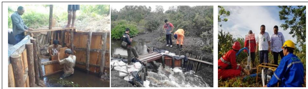
Gambar 5. Pembuatan Sekat Kanal dan Sumur Bor di Lahan Gambut di Kubu Raya
